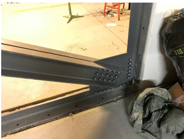
Croix en acier pour le renforcement sismique
