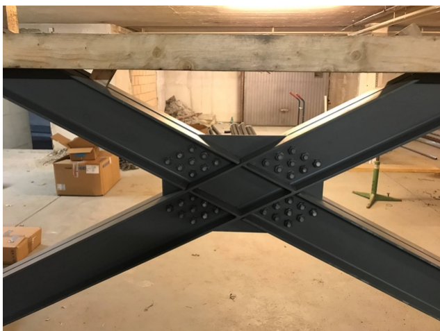
Croix en acier pour le renforcement sismique
