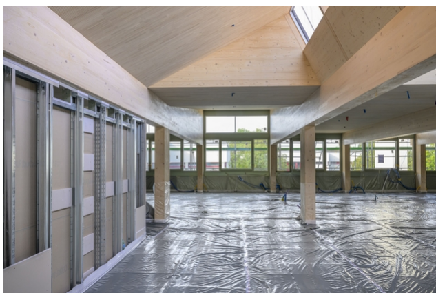
Vue intérieure avec structure en bois et éléments de plafond Lignotrend à effet acoustique
