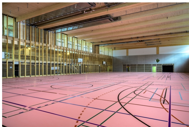
La salle de sport triple située en dessous, avec ses poutres en bois (longueur : 35 m)
