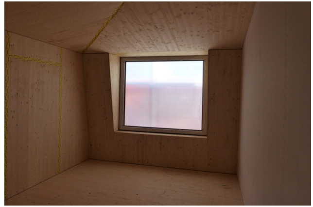
Innenansicht während der Bauphase
