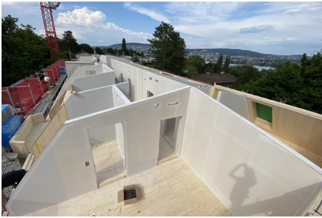
Ansicht direkt in den Elementbau Aufstockung
