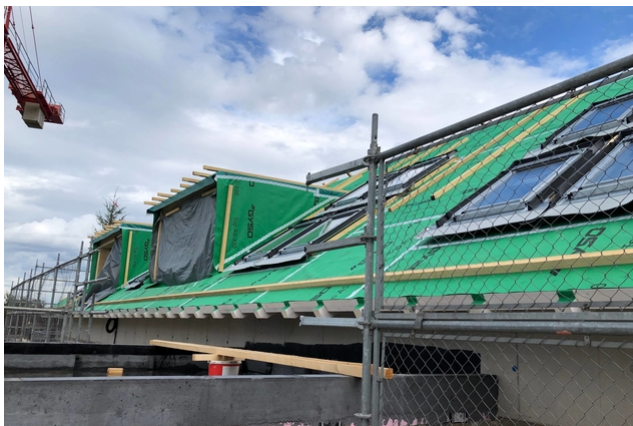
Aufstockung in der Bauphase
