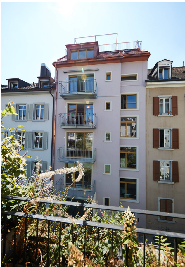
Ansicht Gebäude von aussen
