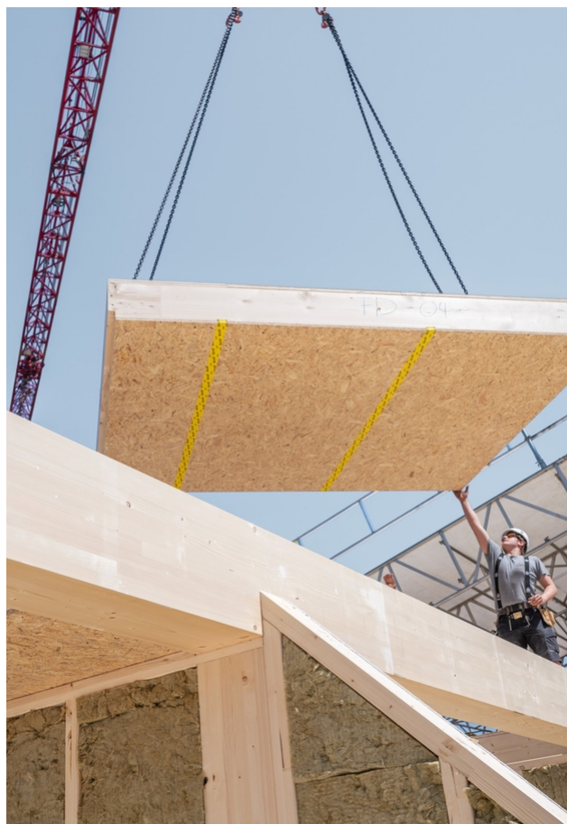
Einbringen von Geschosselementen
