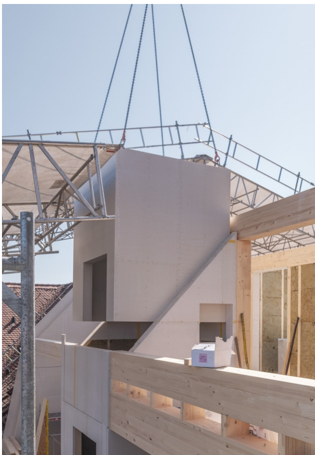
Vorgefertigte Module werden bauseits eingebracht
