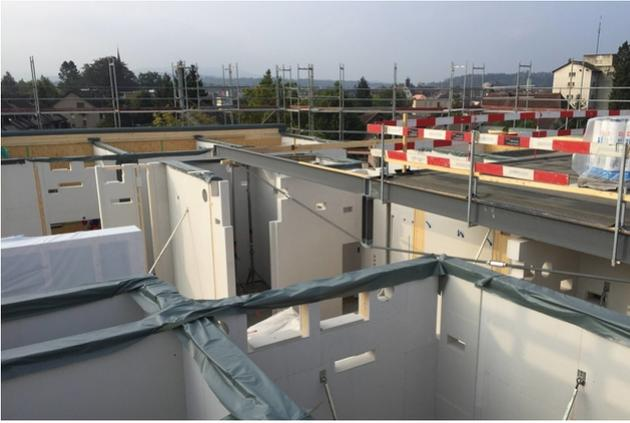
Einbau des unterspannten Unterzugs
