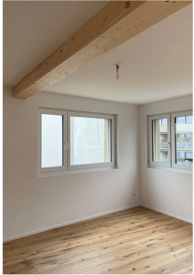
Unterzug aus Brettschichtholz
