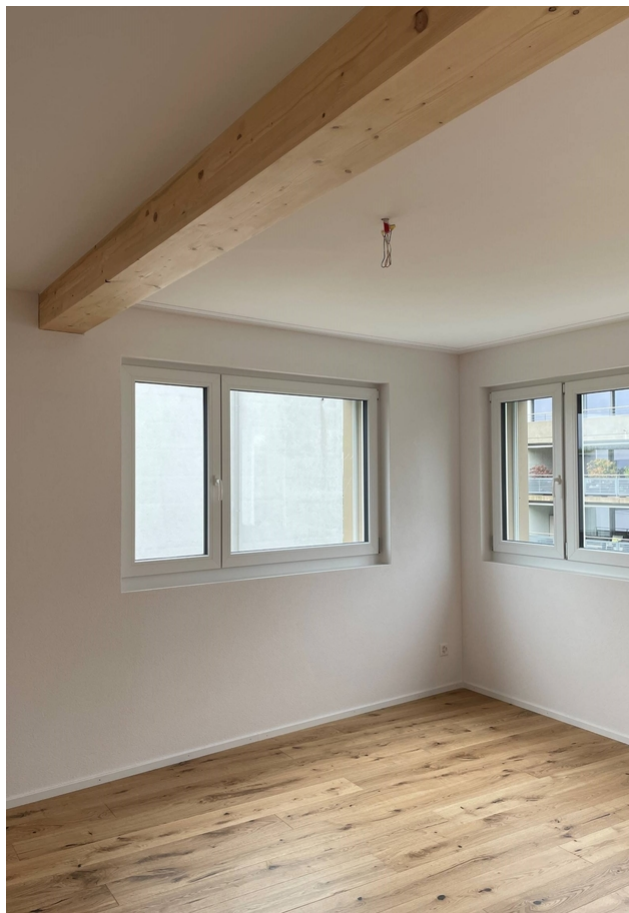
Unterzug aus Brettschichtholz
