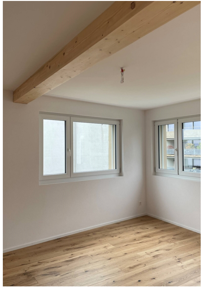
Unterzug aus Brettschichtholz
