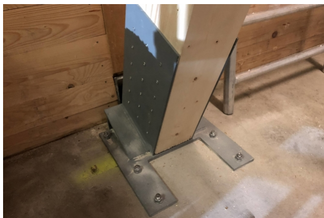
Strebenanschluss unten
