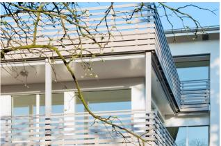
Das bestehende Mehrfamilienhaus an der Salvatorstrasse wurde einer Gesamtsanierung unterzogen, um mehr Raum, Komfort und Ästhetik zu schaffen. Die Wohnraumerweiterung besteht aus Hohlkastenelementen, die frontseitig auf einer Pfosten- und Pfettenkonstruktion ruht und mit einer Glasfront bekleidet ist.
