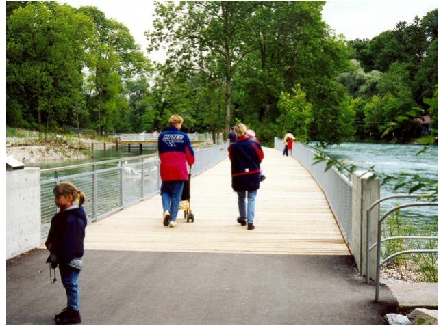
Der Beginn der Brücke
