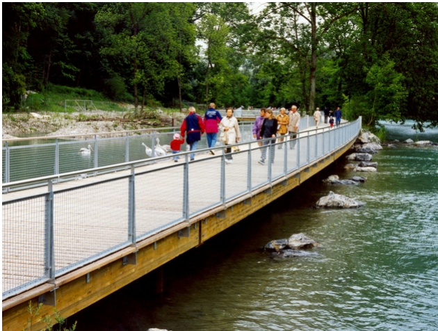
Fußgängerweg in Betrieb
