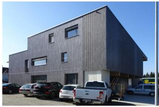
In Aefligen zwischen Bern und Solothurn entstand ein Gewerbegebäude mit verschiedenen Nebenräumen. Der Baukörper mit einem Volumen von über 6'000 Kubikmetern überzeugt mit seiner Tragstruktur und der Fassade aus Holz.
