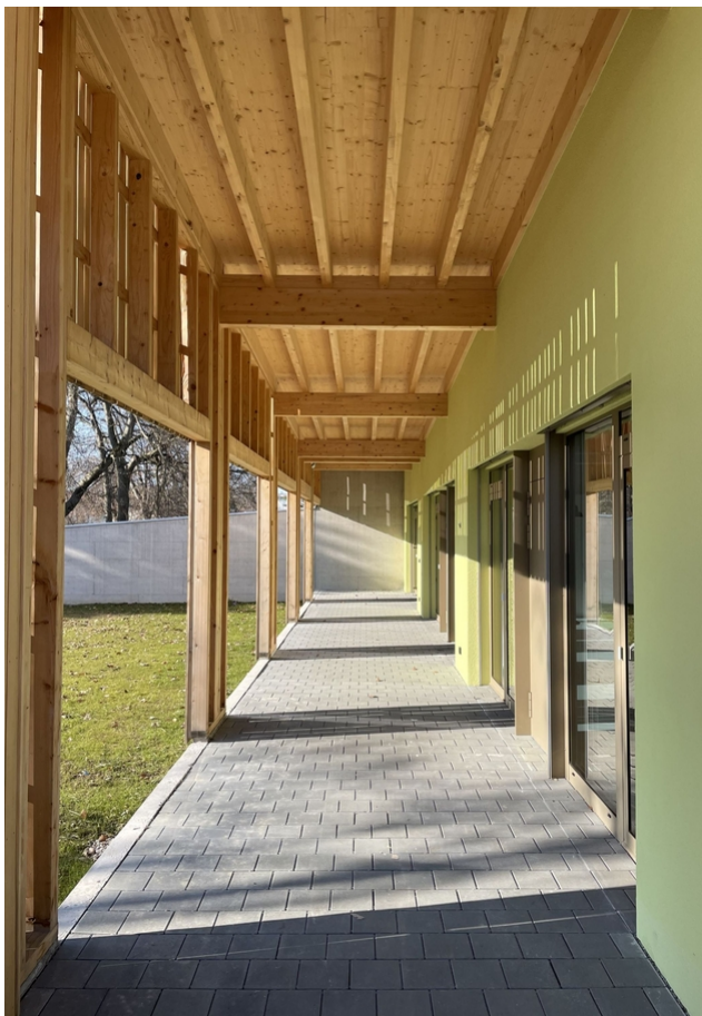
Der Laubengang mit den sichtbaren Unterzügen
