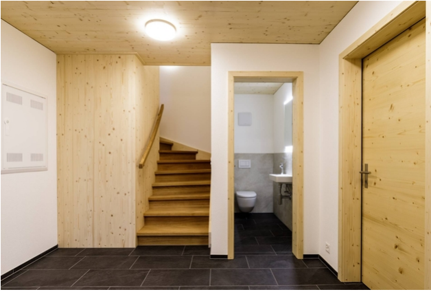
Massivholzdecken schaffen eine angenehme Atmosphäre in diesem Ersatzgebäude.
