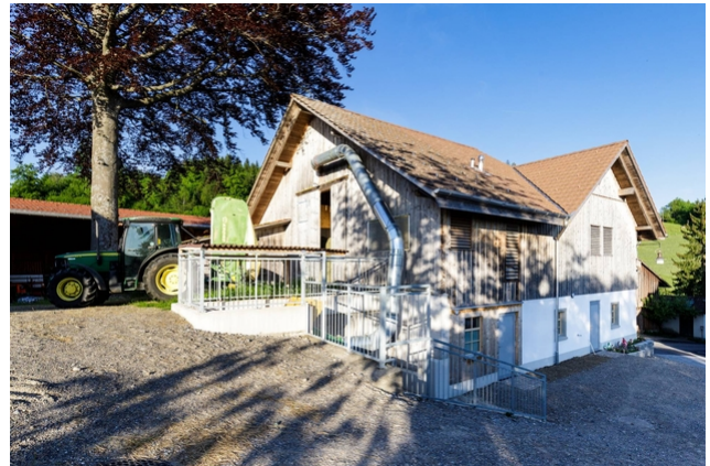
Umbau Scheune zu Betriebsgebäude
