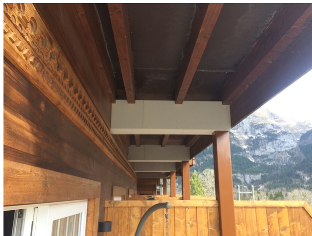
HEB Träger verkleidet
