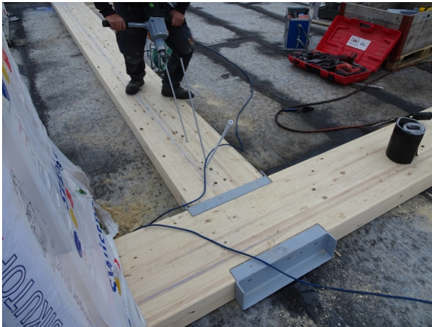
Verstärkung von oben
