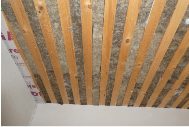
Deckendämmung im Scheunenumbau.
