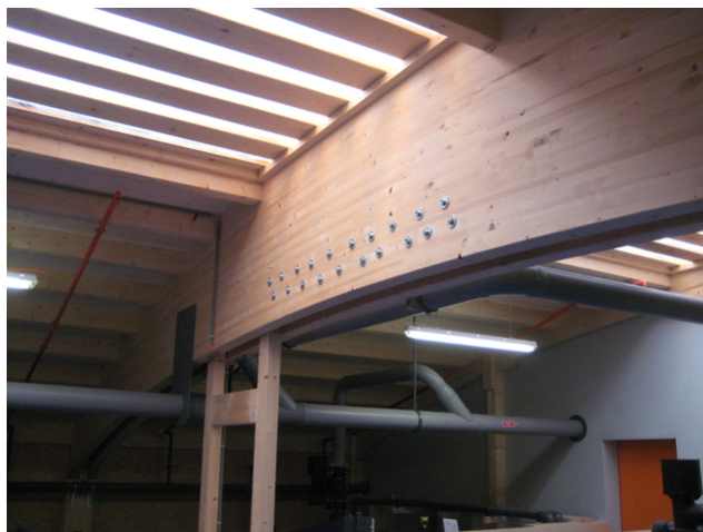
Zusammenschluss Dachschalen
