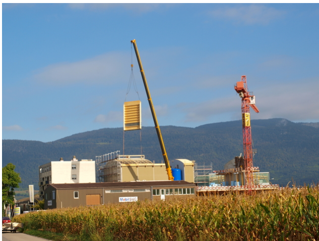
Montage Aussenwände
