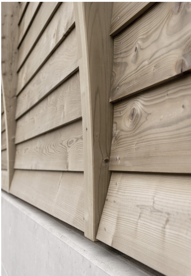
Detail Fassadenschalung
