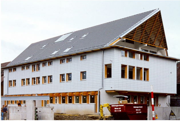
Ansicht von der Strasse
