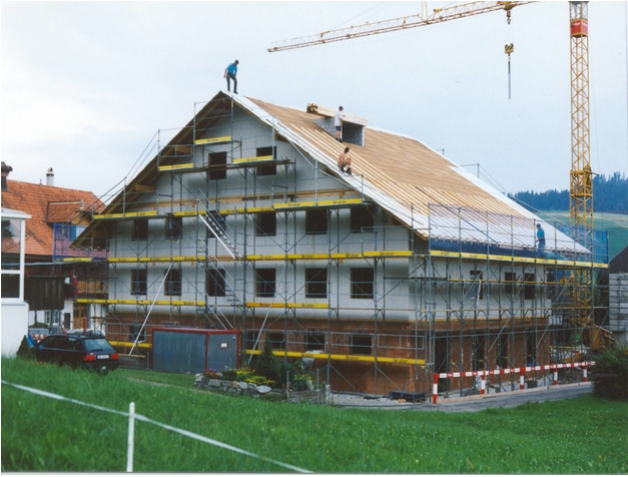
In der Bauphase
