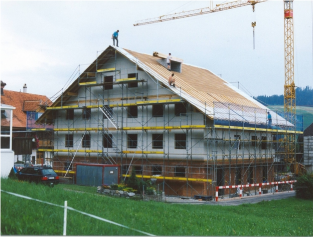
In der Bauphase
