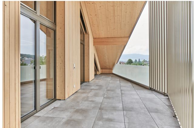
Im Dorfzentrum von Gretzenbach im Kanton Solothurn entstand ein Holzbau mit zwölf Wohnungen und einem Dorfladen. Die Balkone kragen über 3.5 Meter aus – dies ohne störende Stützen. Eine ausgeklügelte, aufgehängte Konstruktion macht es möglich.
