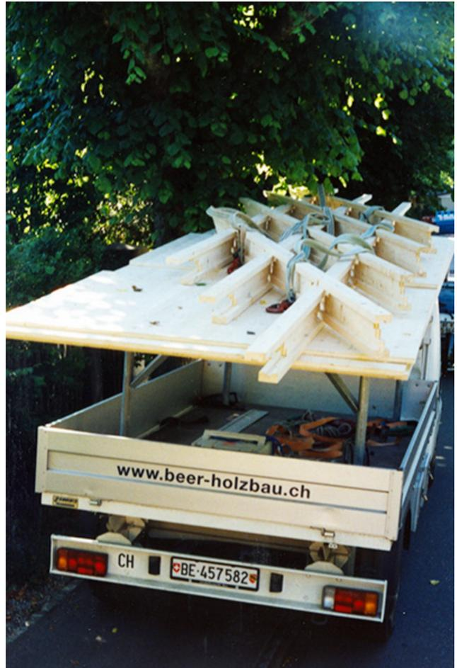
Anlieferung zusammengeklappter Trägerrost
