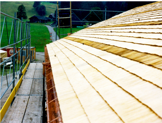
Schindelarbeiten
