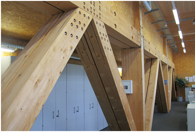
Fachwerkträger im Bürotrakt
