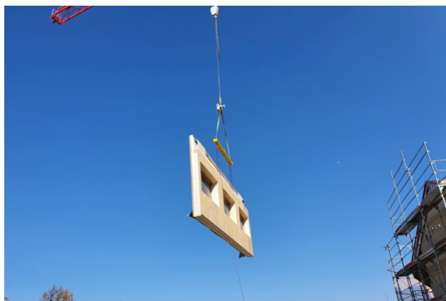
Aufrichten der Holzbauelemente
