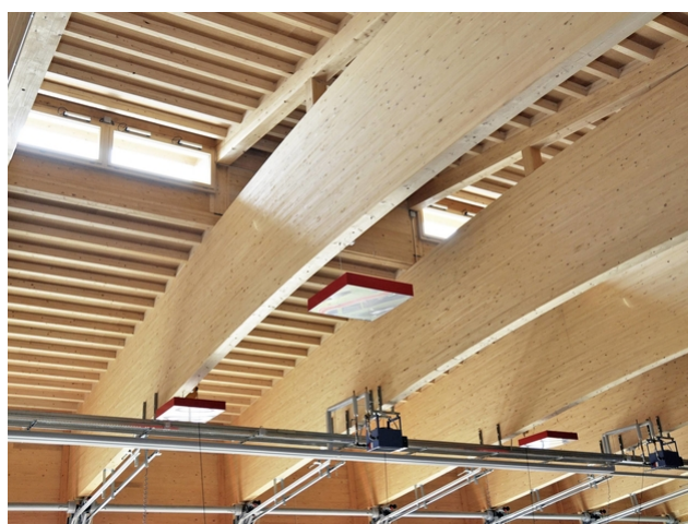
Detailaufnahme der grossen und schweren Holz-Bogenbinder
