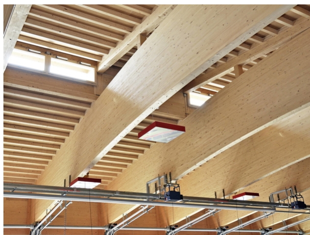
Detailaufnahme der grossen und schweren Holz-Bogenbinder
