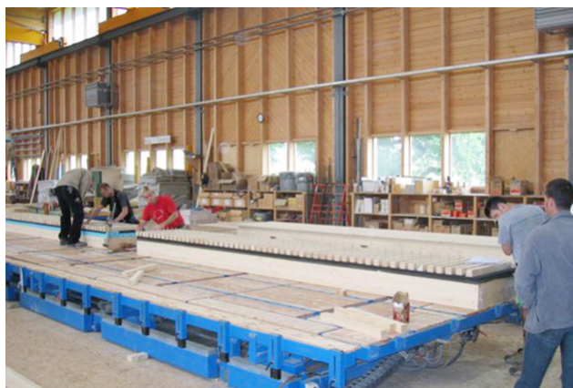
Herstellung von Dachelementen
