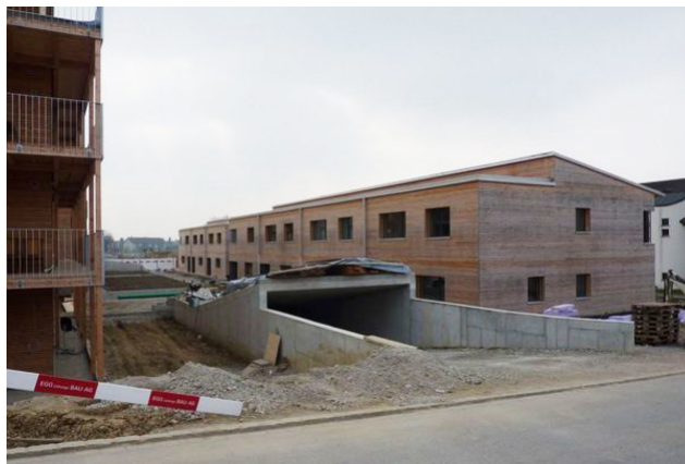
Eingang zur Tiefgarage
