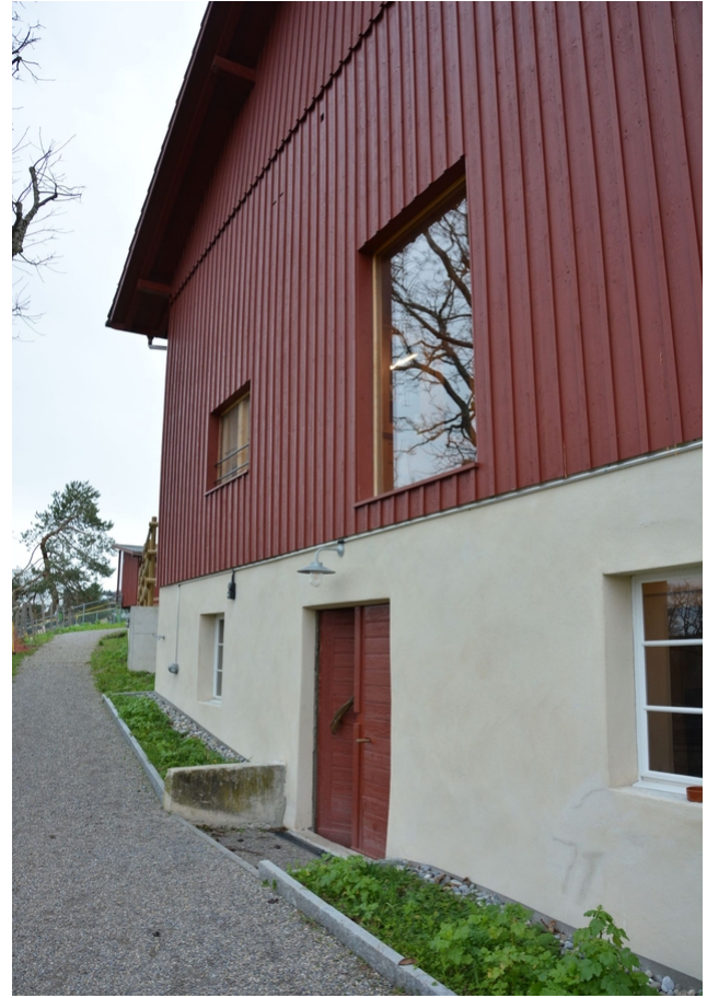
Rot gestrichene Fassade
