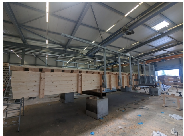
Préfabrication du pont dans les Ateliers de JPF-Ducret.
