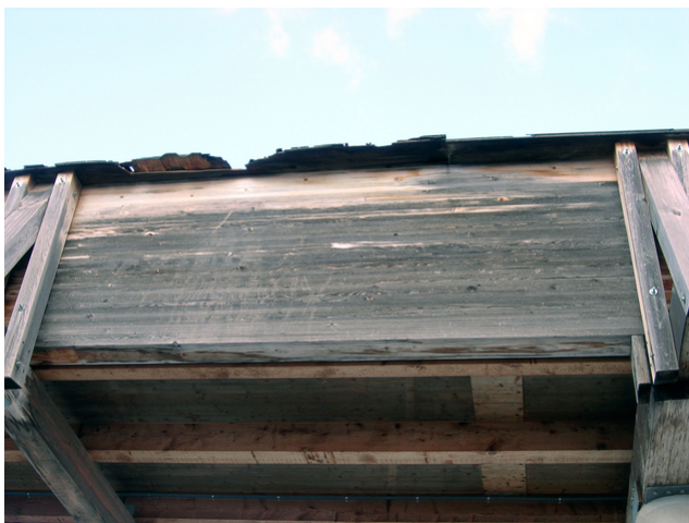
Fußgängerbrücke vor der Sanierung 2
