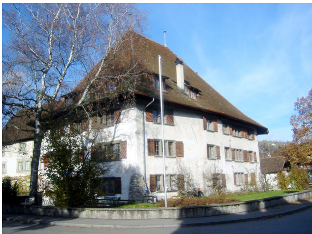
Aussenbereich vor der Renovierung
