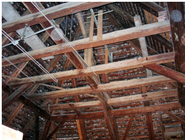
Dachgeschoss vor der Renovierung
