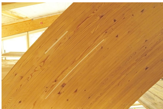
Detailansicht einer sanierten Klebstofffuge
