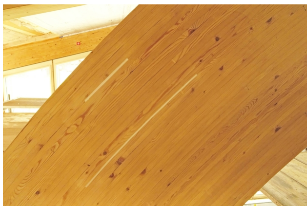
Detailansicht einer sanierten Klebstoffuge
