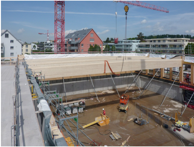
Einbau von Dachgepäckträgern für die neue Sporthalle
