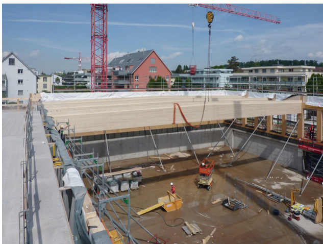
Einbau von Dachgepäckträgern für die neue Sporthalle
