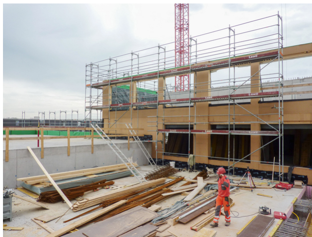
Holzelemente für die neue Schulanlage im Bau
