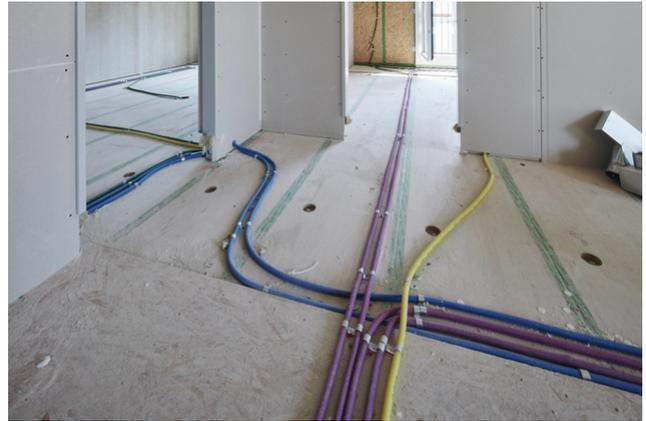
Ein Holzbau ist erst dann ein richtiger Holzbau, wenn er ohne Beton auskommt. Darum gehören Holz-Beton-Verbunddecken bei uns bereits zur Vergangenheit. Eingesetzt werden stattdessen elastisch gebundene Splittschüttungen.
