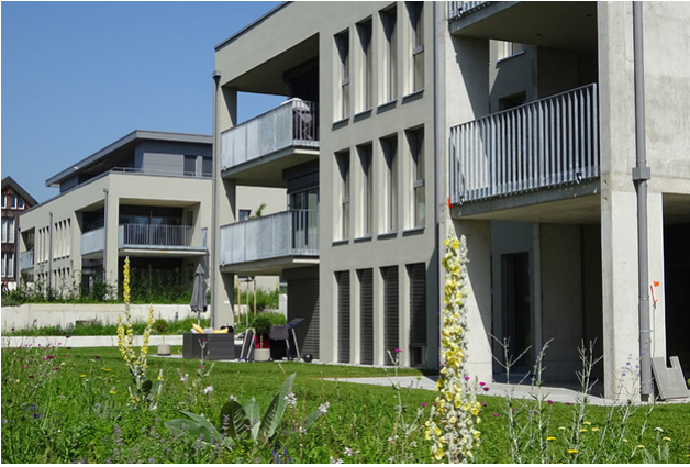
Aussenansicht fertige Überbauung
