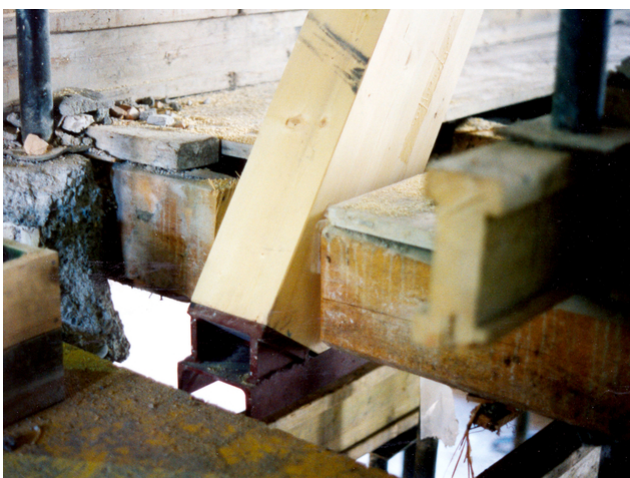
UNP-Träger, Endstütze Traverse
