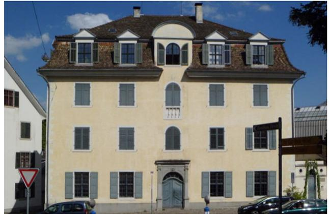
Das barocke Haus zum Kiel steht am Hirschengraben in der Zürcher Altstadt. Der Bau wies starke Setzungen und diverse Schäden an Baustruktur und Tragstruktur auf. Die Timbatec AG wurde beauftragt, Lastabtragungswege zu prüfen und Massnahmen im Umbau zu definieren.
