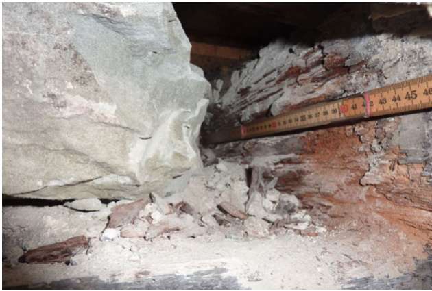
Deckenbalkenstütze in der Aussenwand im Weinkeller vor der Sanierung
