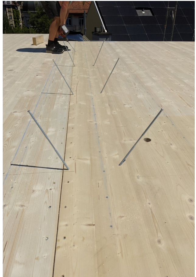
Verschraubung der Dachelemente
