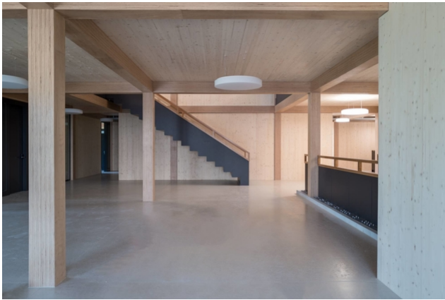
Innenansicht mit Buchenstützen
