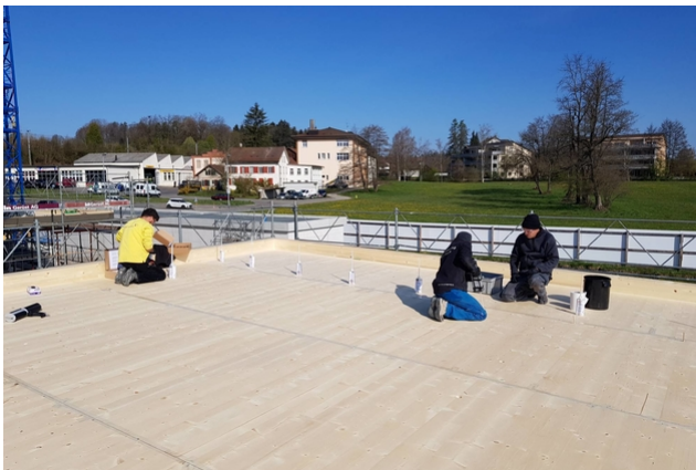
TS3 beim TS3-Verguss des Vordachs
