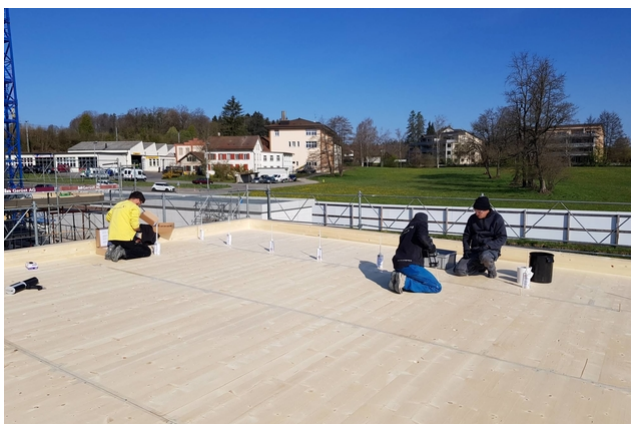
TS3 beim TS3-Verguss des Vordachs
